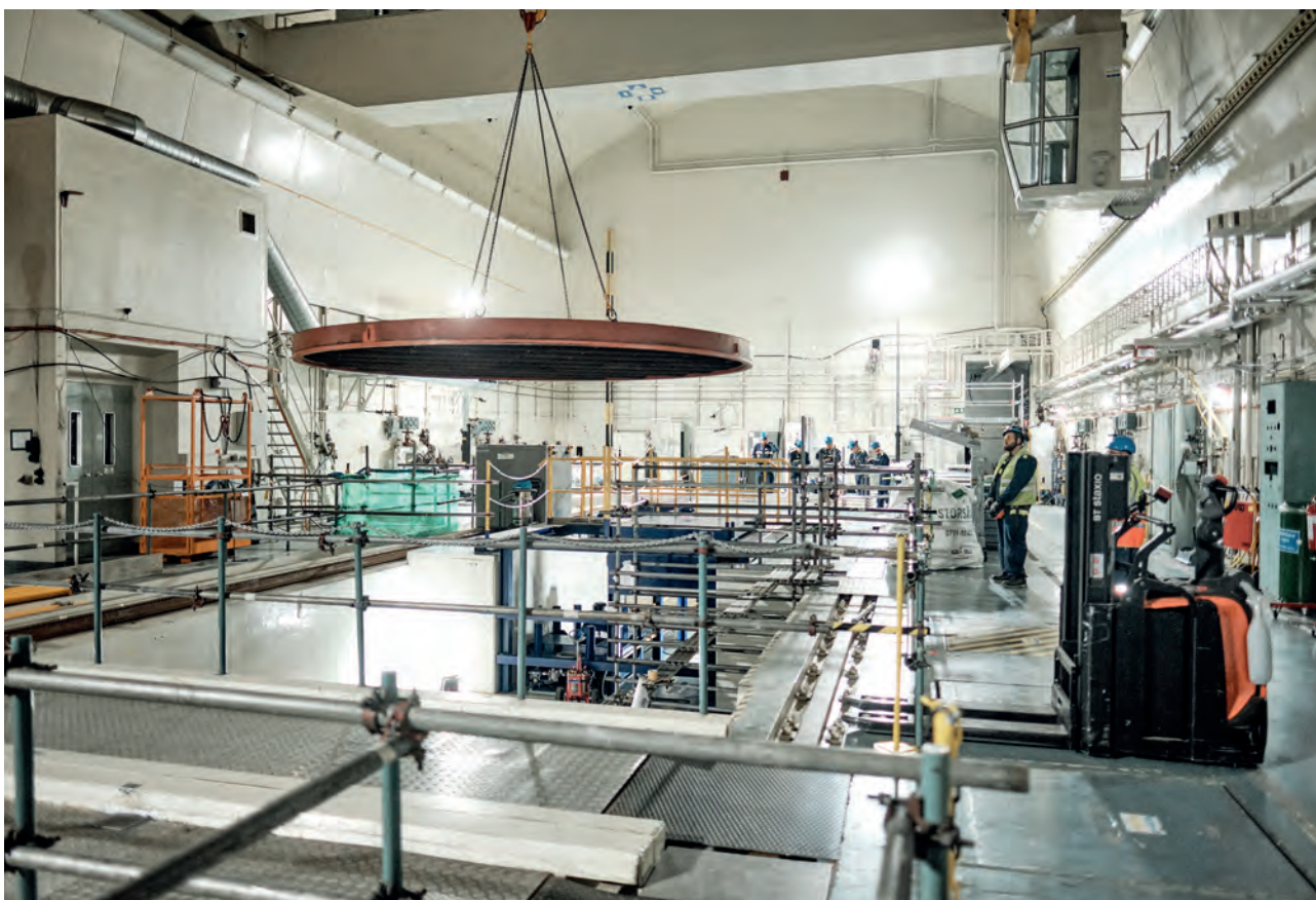
Ett av reaktortankens tre lock i luften. Foto: Vattenfall/John Guthed
