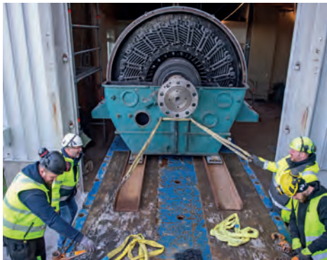
Generatoren vinschas fram på flaket. Foto: Vattenfall/Ryno Quantz
