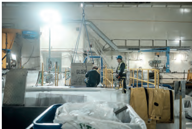
Materialet packas i ett strålsäkert emballage inför borttransport. Foto: Vattenfall/John Guthed
