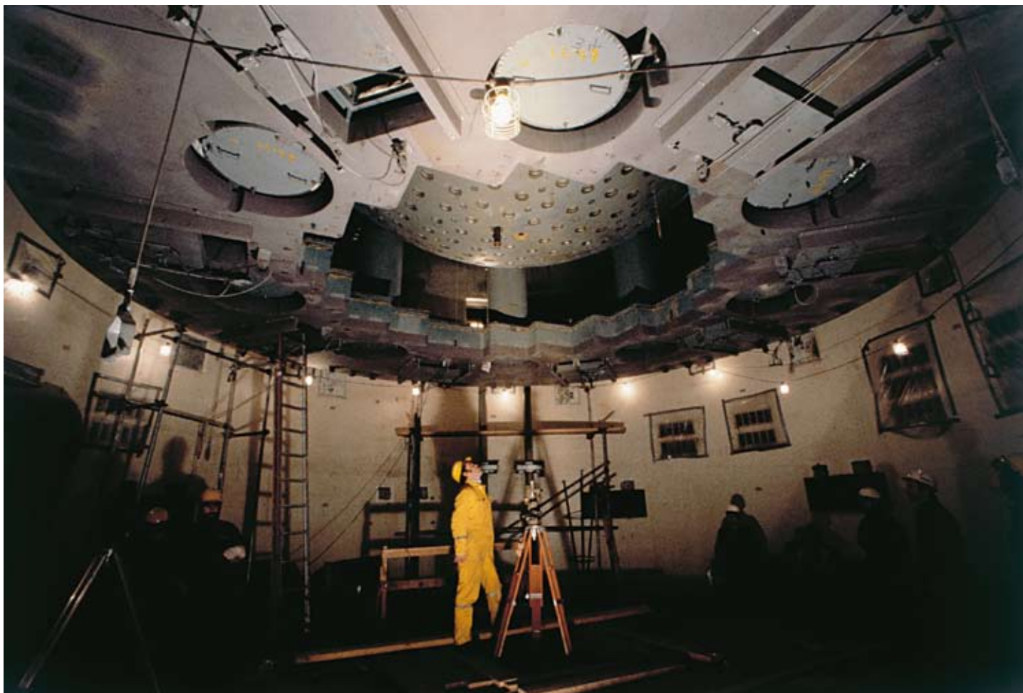
Reaktortanken firas ner i reaktorinneslutningen på Forsmark 2 i november 1977.
