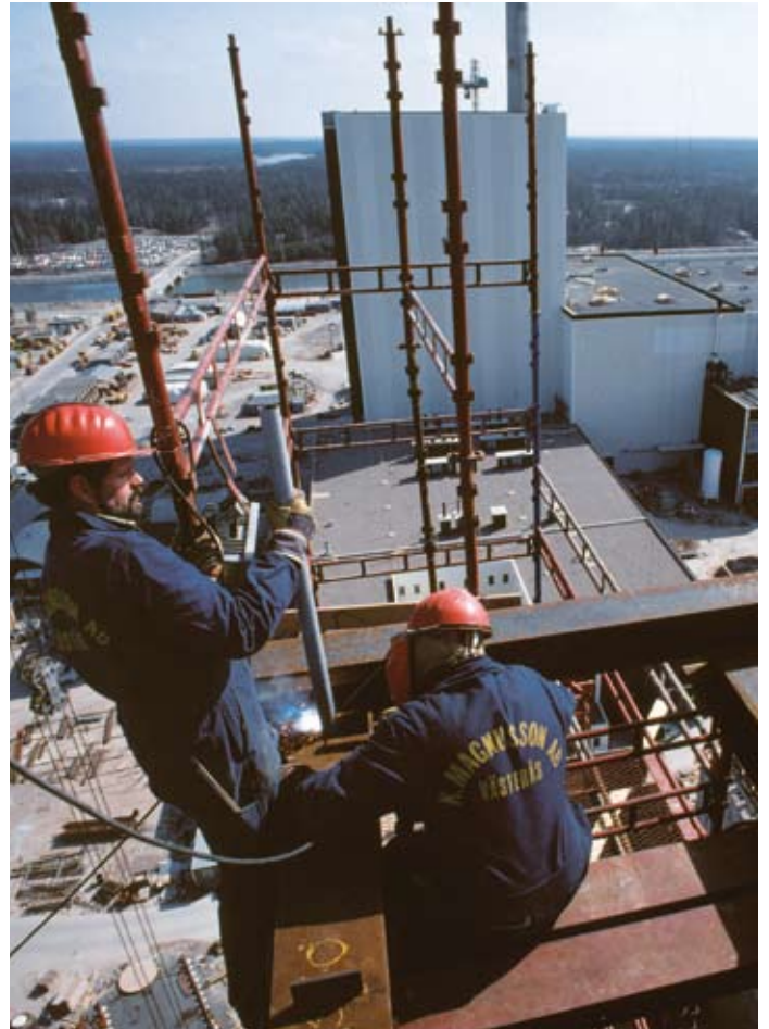
Arbete på hög nivå vid bygget av Forsmark 2 i april 1977. Forsmark 1 syns i bakgrunden.
