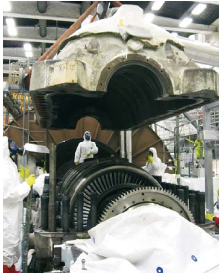
Förberedelse för effekthöjning. Ny högtrycksturbin installerades på Forsmark 2 under revisionen 2009.
