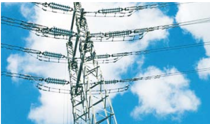
I samband med arbete i 400kV-ställverket inträffade en större störning på Forsmark 1 den 25 juli 2006. Många åtgärder vidtogs för att förbättra säkerheten efter incidenten. Strålsäkerhetsmyndigheten tillsatte särskilda tillsyn som hävdades 2009.
