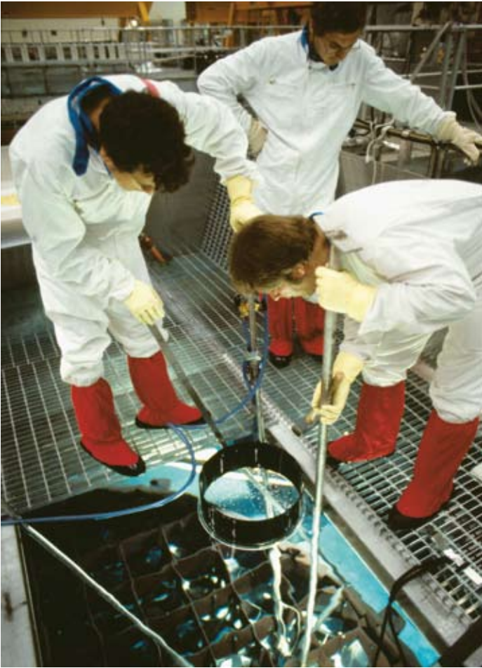
Vid revisionen i juli 1982 upptäcktes att några skruvar till glidskenorna i härdgallret hade brustit på Forsmark 2. Samtliga bultar byttes ut på Forsmark 1 och 2, totalt 1 400 stycken.
