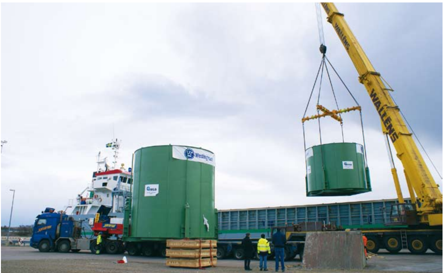
Interndelar till reaktorn ska installeras på Forsmark 1 under sommarens revision 2010. Här anländer fuktavskiljare och moderatortanklock med båt från Spanien. Delarna väger cirka 50 ton styck.
