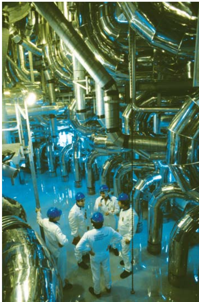
Inspektionsrunda i reaktorinneslutningen på Forsmark 3 före driftsättningen. Bilden är tagen i november 1984.
