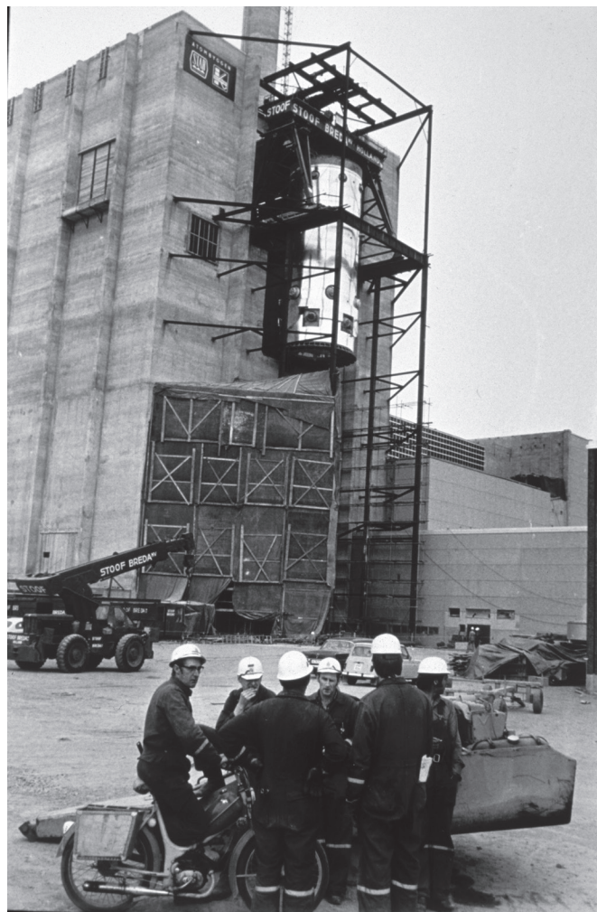
En bild från byggtiden: reaktortanken på R1 lyfts in.
