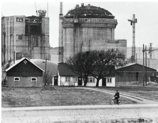
Siluetten i Bua förändrades i och med att Ringhals etablerades. Reaktorbyggnaderna reste sig stora i kontrast till bygdens små gårdar och jordbruk.
